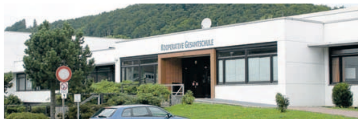
Die Kooperative Gesamtschule will eine „Bewegte Schule“ werden.
